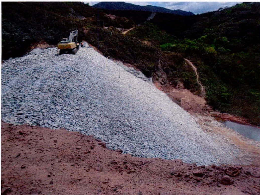
Figura 19: Visão geral da obra de drenagem junto ao pé do talude à jusante do dique de sela da BCP, ombreira direita. À direita, pequeno represamento de água utilizado para controle de vazão.
