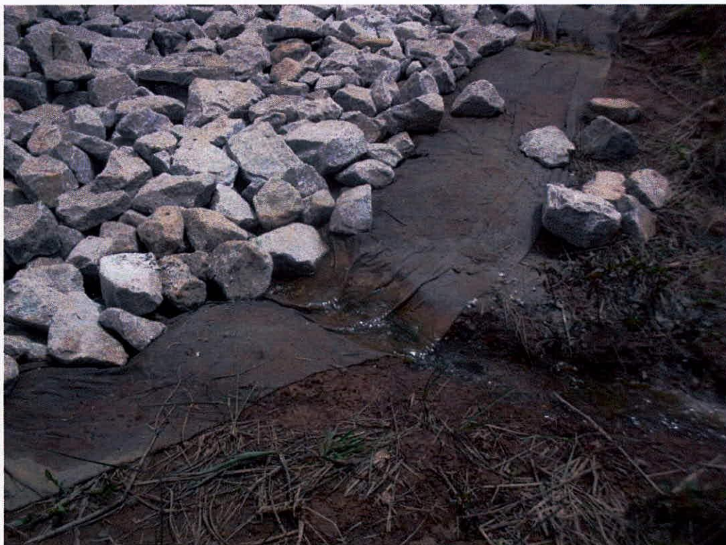
Figura 15: Detalhe da água que corre junto ao pé do talude de jusante do dique de sela da BCP, ombreira esquerda, após a implantação de dreno em pedras de mão e manta.
