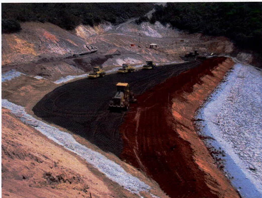
Figura 14: Visão geral da obra que está sendo executada junto ao talude do dique de sela da BCP, ombreira esquerda.
