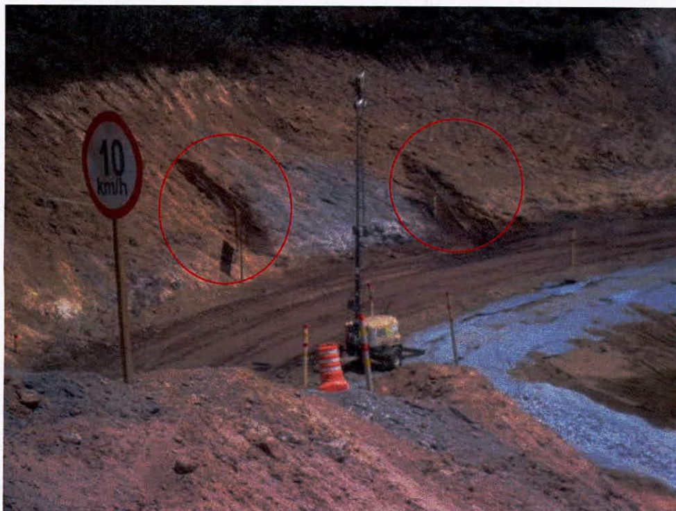
Figura 11: Vistas de drenos sub-horizontais profundos - DHP instalados no talude à jusante do dique de sela da BCP, ombreira esquerda, com a finalidade de aliviar poropressões causadas por excesso de água dentro da estrutura.
