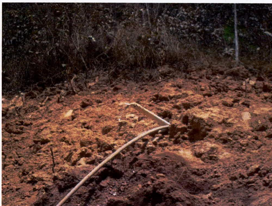
Figura 12: Detalhe de dreno sub-horizantal – DHP instalado no talude à jusante do dique de sela da BCP, ombreira esquerda, com finalidade de drenar as surgências de água.
