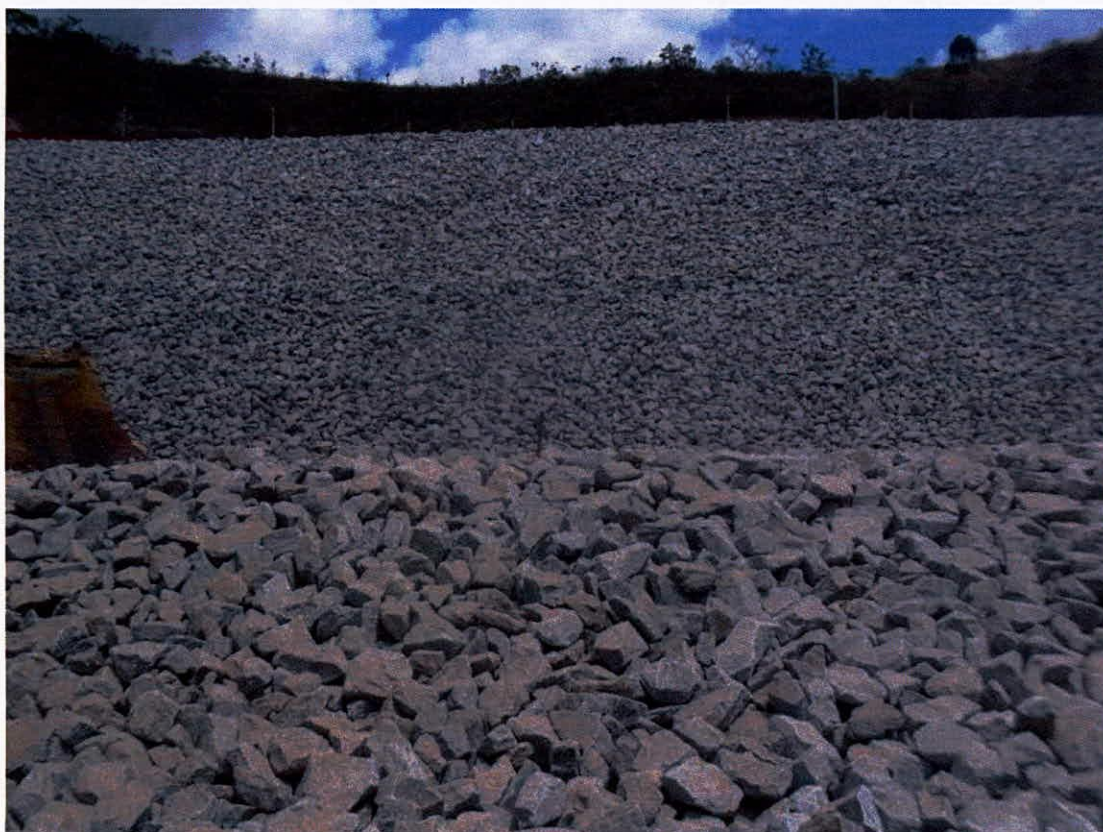
Figura 16: Visão geral da obra com implantação de DHP e filtro invertido executada junto ao pé do talude de jusante do dique de sela da BCP, ombreira esquerda, até o momento com aproximadamente 15m de altura.
