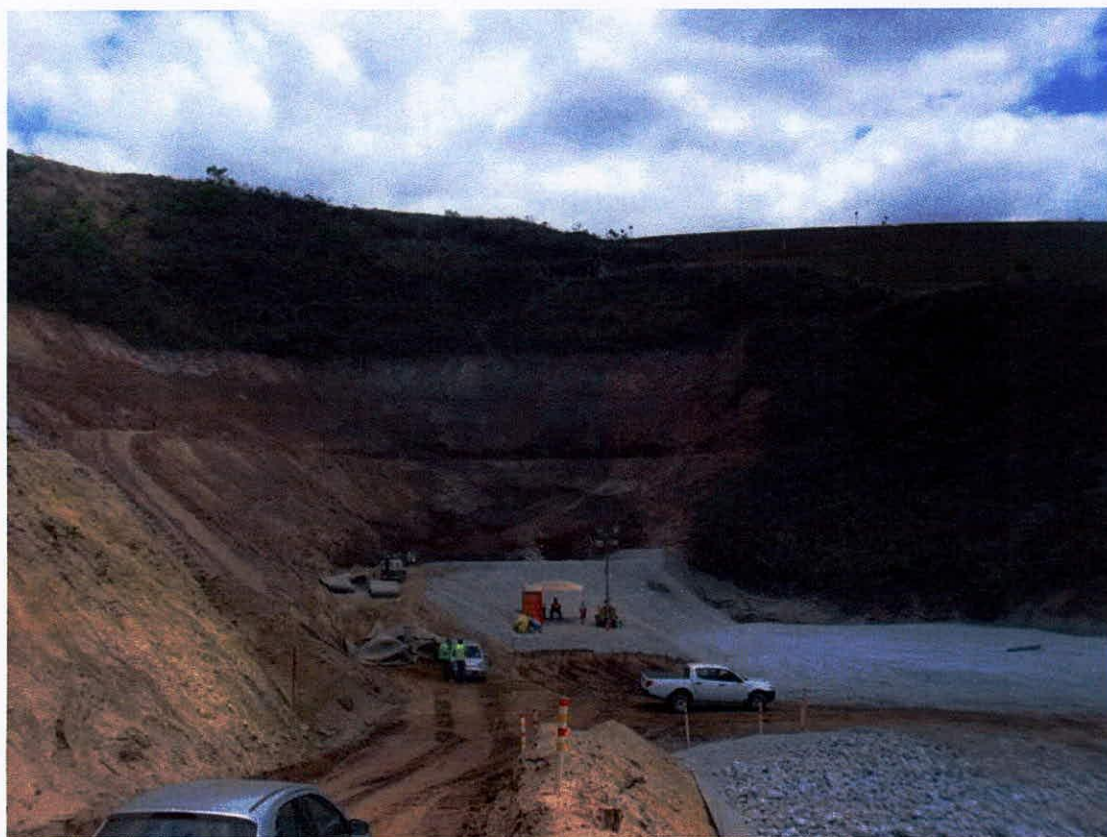
Figura 18: Visão geral da obra de drenagem que está sendo executada junto ao talude do dique de sela da BCP, ombreira direita. Pode-se observar ao fundo, no maciço do barramento, que o terreno está bastante úmido, caracterizando a farta ocorrência de surgências no talude.
