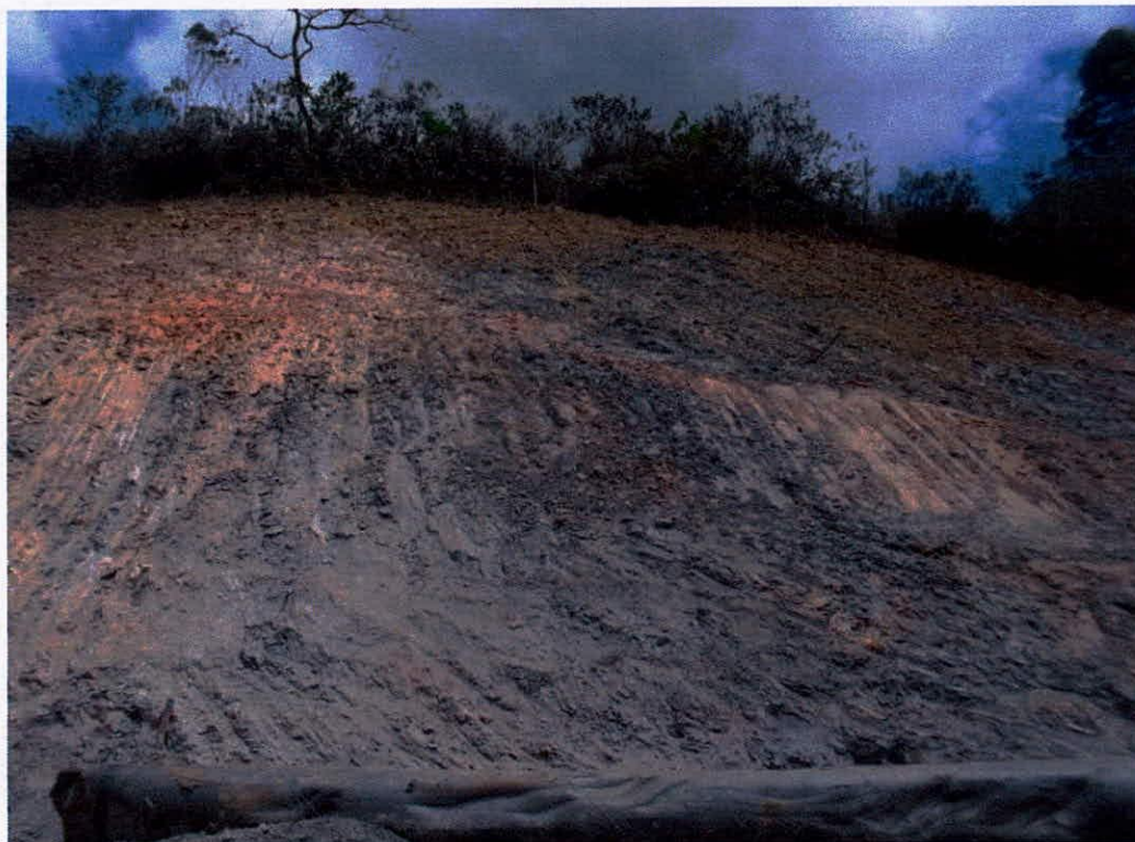
Figura 13: Detalhe do talude à jusante do dique de sela da BCP, ombreira esquerda, já preparado para receber bermas de reforço em solo compactado, no local foi instalado DHP e está sendo construído filtros invertidos com particulados, finos, médios e grossos (areia e brita) além de colocação de manta com a finalidade de conter o carreamento de particulados sólidos durante a percolação de água no maciço da barragem.
