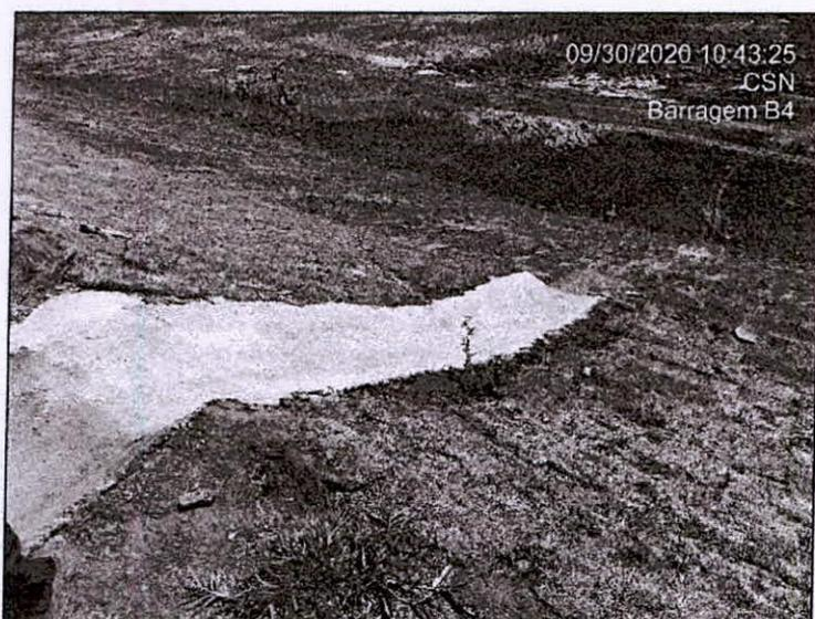
Foto 44 – Descida d'água no talude de montante.
