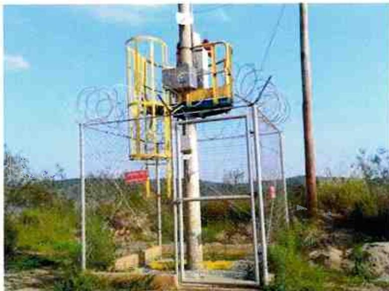
As caixas utilizadas para proteger os equipamentos do Subsistema de Aviso nas torres são fechadas por cadeados ou fechaduras.
