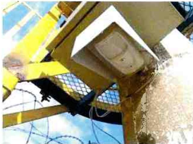
As câmeras fixas instaladas nas torres são dotadas de microfones de maneira a registrarem e enviarem feedback à Central de Monitoramento sobre os acionamentos reais e possíveis testes dos alarmes. Além disso, todo o sistema é protegido por cerca com alambrado e concertina. O acesso aos módulos se dá por meio de portão trancado por fechadura de chave tetra.
